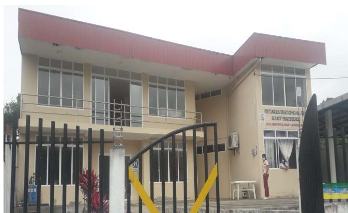
Imagen 10. Centro de Rehabilitación Elaborado por: Ing. Luis Villacreses Quimíz
